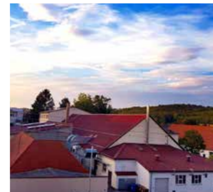
Anbau einer Lagerhalle an die bestehenden Gebäude Extension of the existing buildings with a new warehouse
